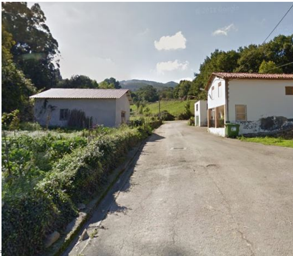
Punto de inicio de la red de saneamiento
