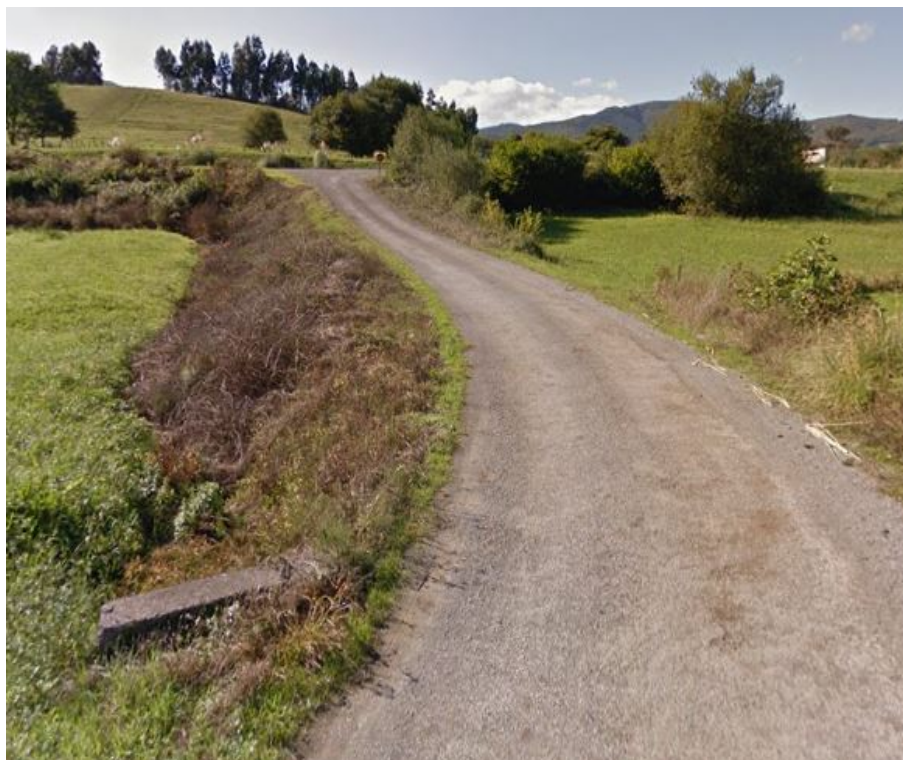
Tramo 3: Zona de bombeo
