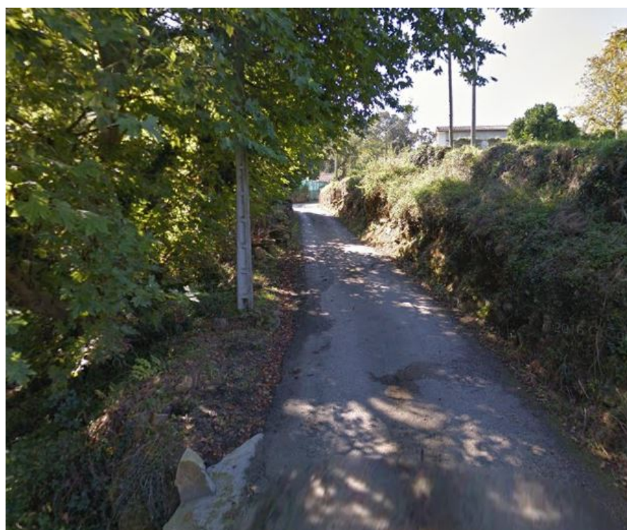
Tramo 1: Junto al arroyo
